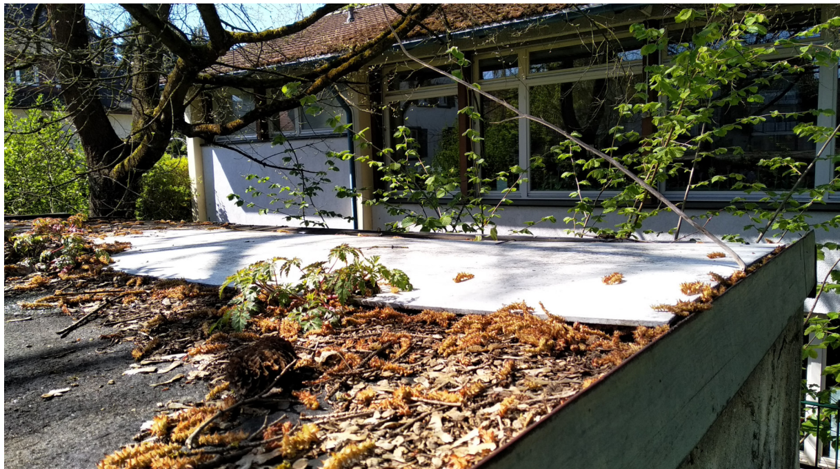
lose Asbestzementplatte auf Garagendach vorn
