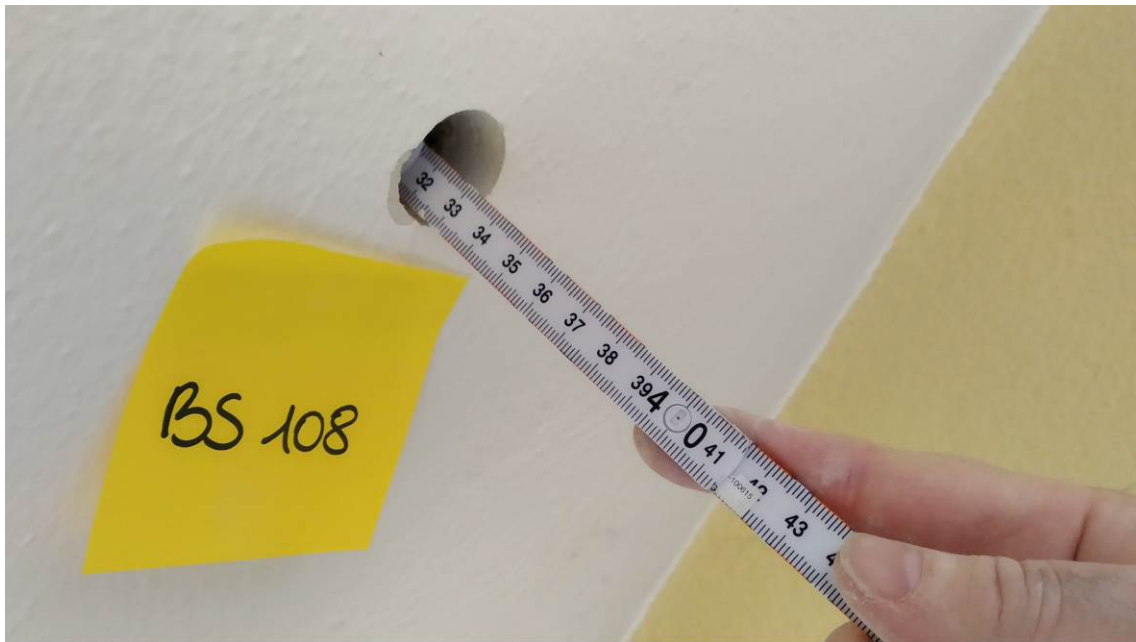
Gipskarton + Styropor in Dachschräge Treppenhaus [BS108]
